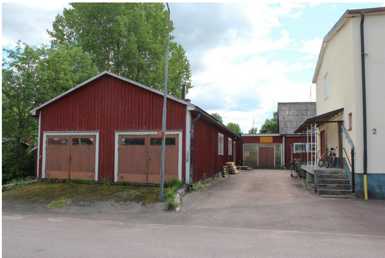
Kallager och garage i de båda röda byggnaderna
